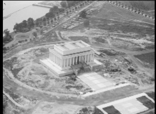
La construction du monument de Lincoln, 1919
