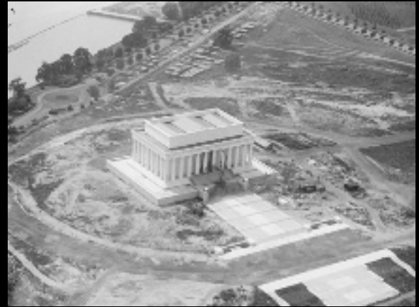
El Monumento a Lincoln durante su construcción, 1919
